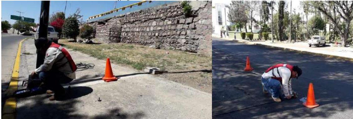
Fotografía 18 Colocación de Aforos Automáticos
