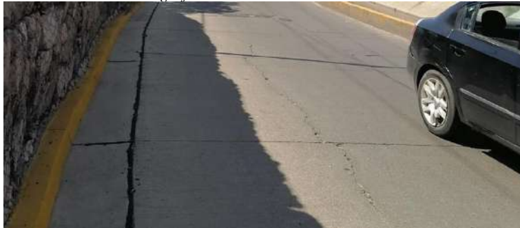
Fotografía 4 Condiciones del Pavimento
