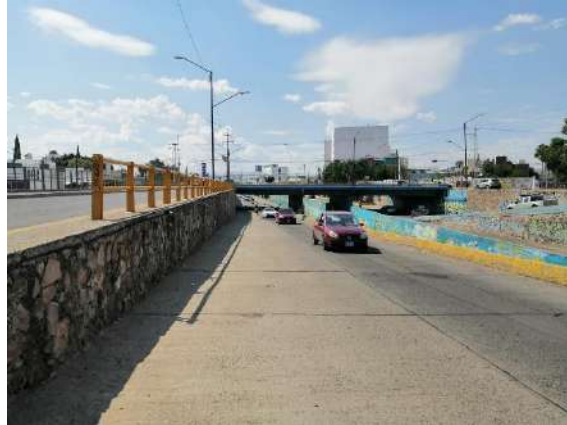
Fotografía 15 Tramo 5A Después del Puente Niza
