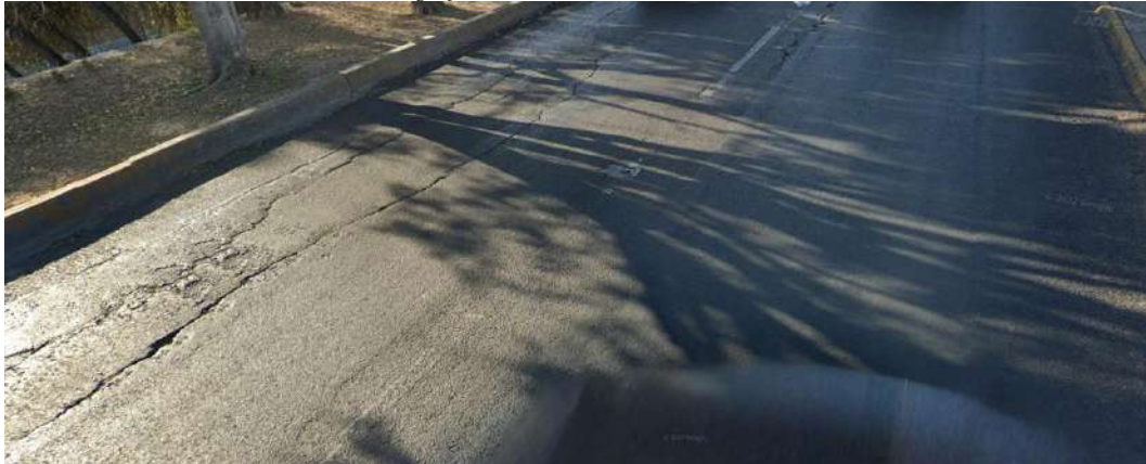
Fotografía 7 Condiciones del Pavimento
