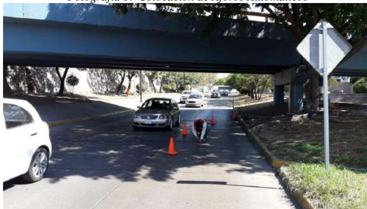
Fotografía 17 Colocación de Aforos Automáticos
