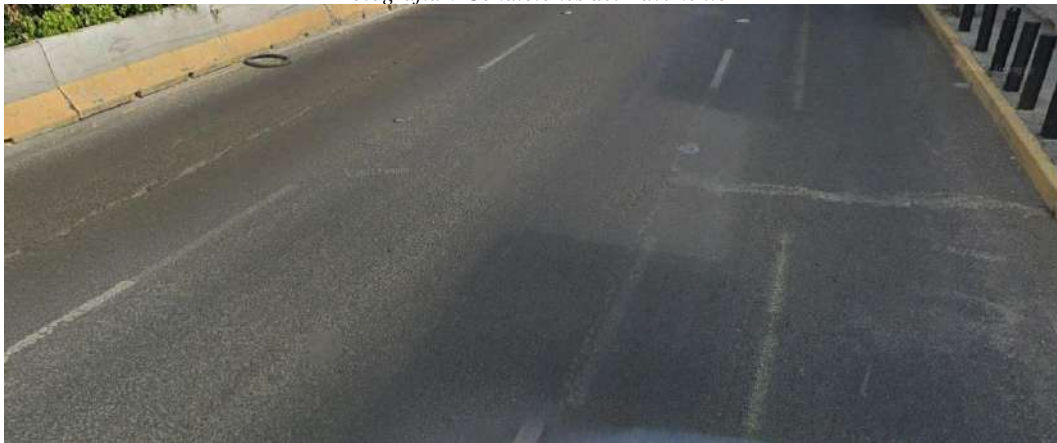
Fotografía 6 Condiciones del Pavimento
