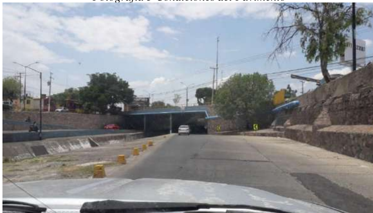
Fotografía 5 Condiciones del Pavimento
